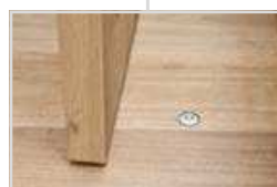
Skrytý magnetický doraz (voliteľne)
